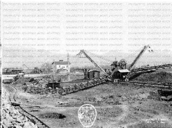
Figg. 63-64. Escavatore n. 3, scavo canale Acque Alte (05/12/1929), (a sinistra); Escavatori a Ponte Marchi, scavo canale Acque Alte (22/02/1929), (a destra).
