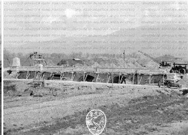
Figg. 65-66. Escavatore Tosi n. 3, scavo canale Acque Alte a valle Ponte Campomaggiore (04/10/1930), (a sinistra); Ponte via Appia sul canale Acque Alte in costruzione (23/03/1931), (a destra).
